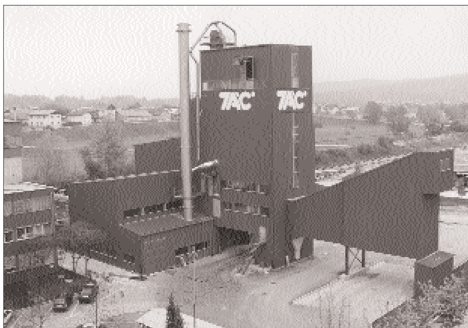
Tovarna asfalta Črnuče
